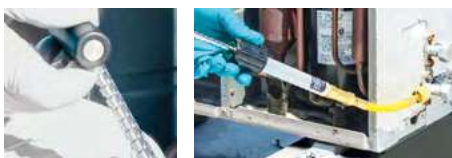
Wprowadzanie uszczelnacza za pomocą dozownika.
