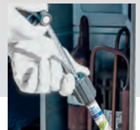
Injektion du colorant en tournant la poignée.
