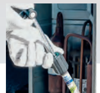
Injection du colorant en tournant la poignée.
